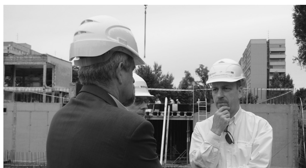
26 sierpnia 2010 r. Wizyta Ministra Kultury i Dziedzictwa Narodowego na placu budowy przy ul. Braniborskiej 59.
